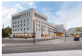
Außenansicht Ernst Leitz Hotel Wetzlar
